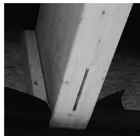
▲ Système de mortaise permettant de glisser le plat métallique dans la poutre en lamellé-collé, et emplacements latéraux des quatre broches de fixation.
