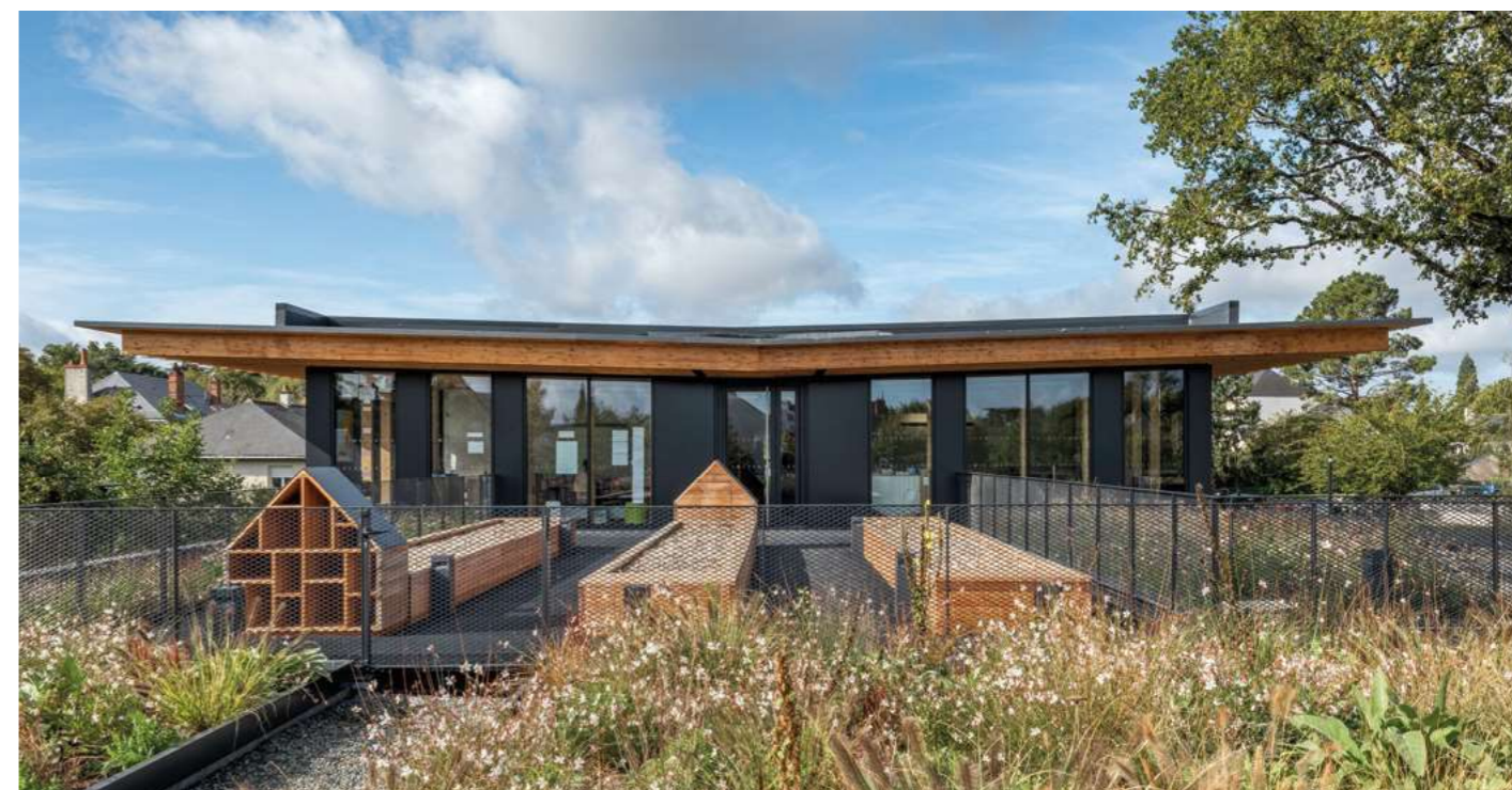
▲ La toiture-terrasse du niveau consacré aux maternelles accueille le jardin pédagogique des élèves de primaire.
