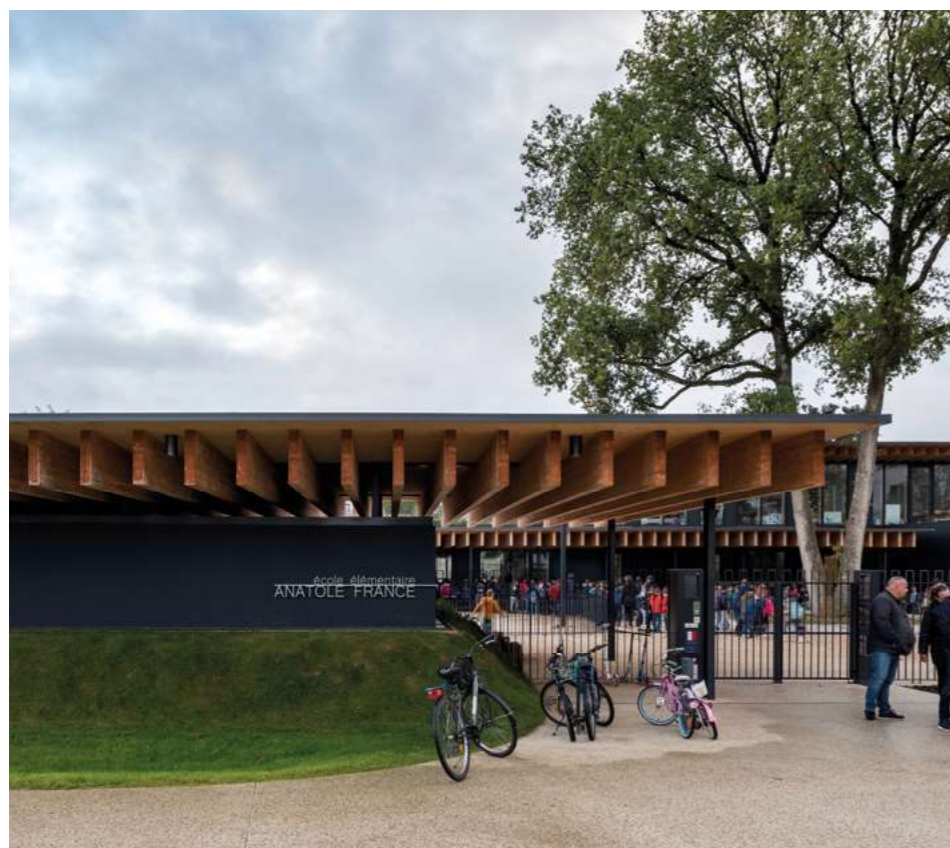
▲ Préau de l'entrée de l'école, dont les arbalétriers d'épicéa semblent léviter : ils sont en fait suspendus à un profilé métallique longitudinal, camouflé dans l'épaisseur de la toiture.
