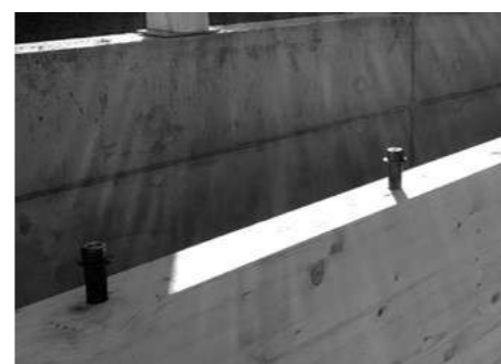
▲ Goujons de connexion entre les poutres bois et la dalle béton de 12 cm qui sera coulée par-dessus, pour supporter les toitures végétalisées accessibles.
