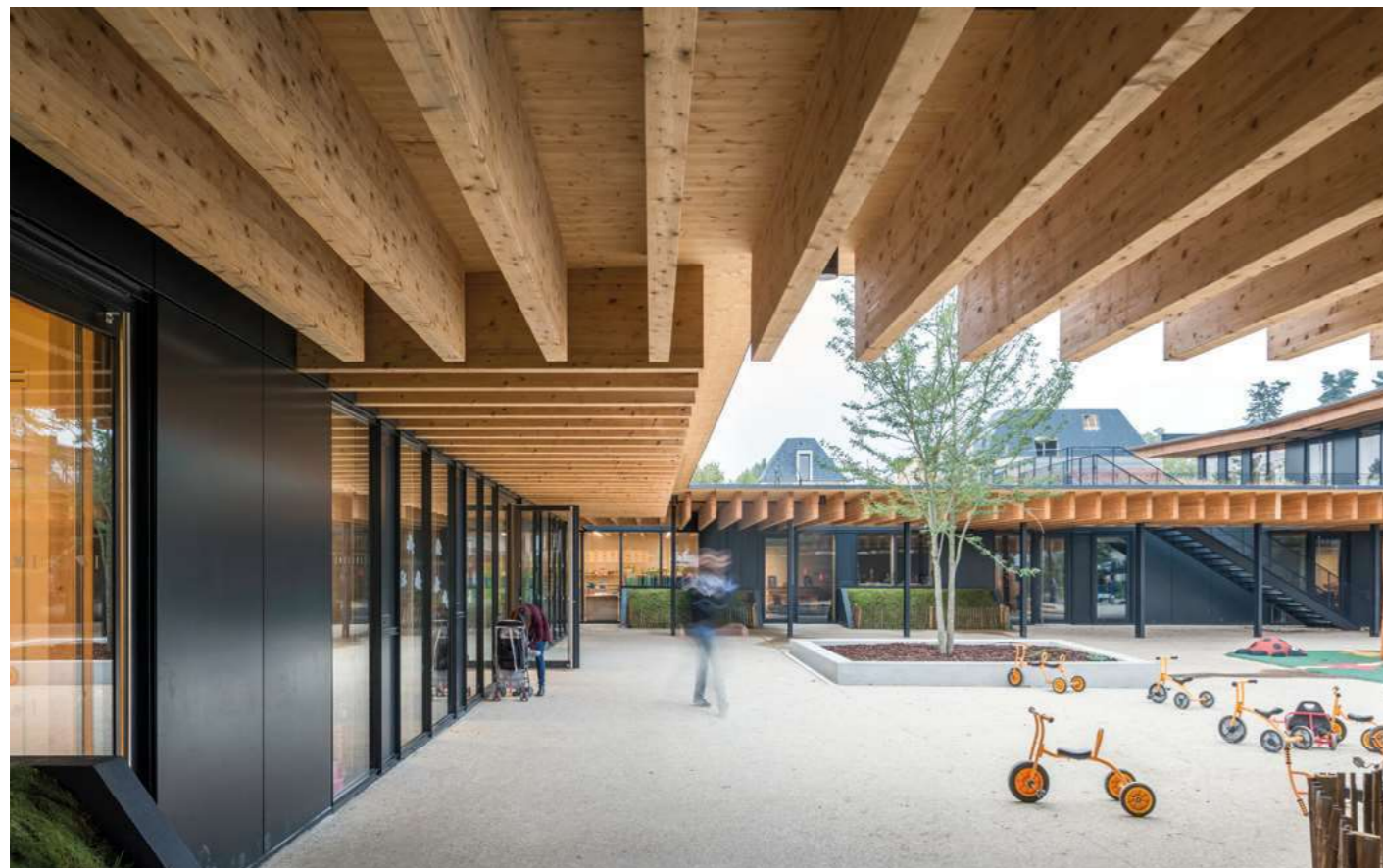
▲ Le métal anthracite s'efface derrière la présence des massives poutres d'épicéa, dont le porte-à-faux sert de préau.
